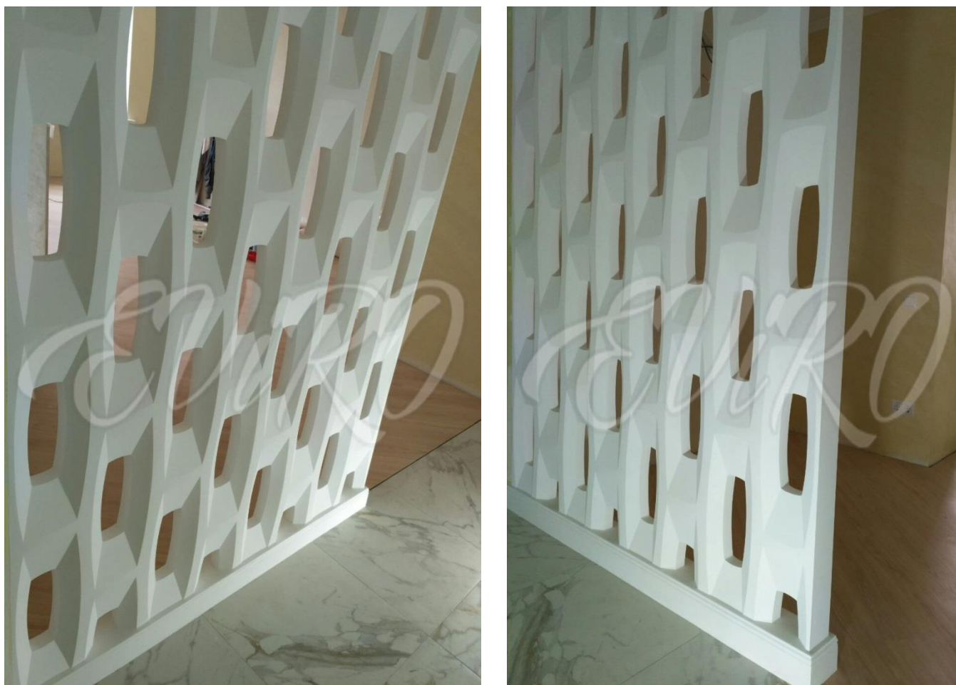
Рис. 4 Выполненный монтаж Гипсовых 3d блоков - перегородок ЕВиРО
